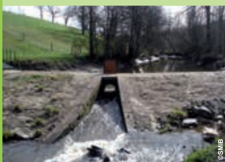
Ouverture des vannes (Beuvron)
