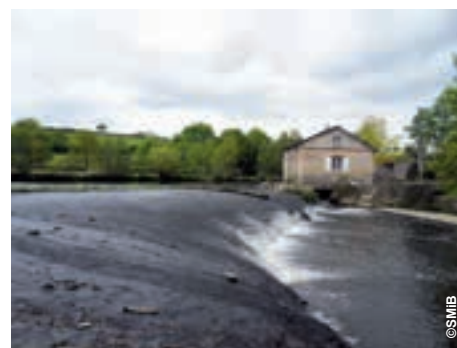
Chaussée de moulin (Èvre)
