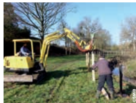
Mise en place d'une clôture
