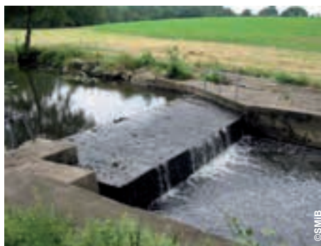
Seuil en béton (Èvre)
