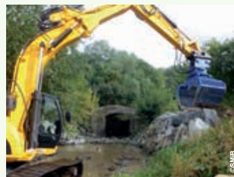
Travaux d'enrochement (réglementés)
