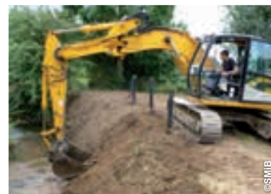
Retalutage de berge
