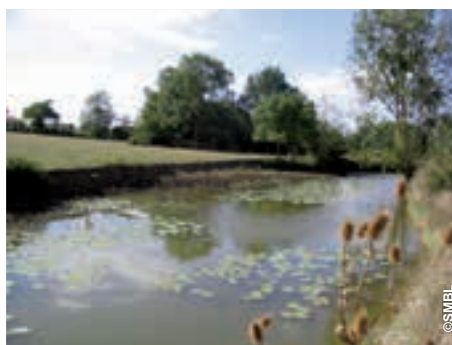
Érosion de berge (piétinement du bétail)
